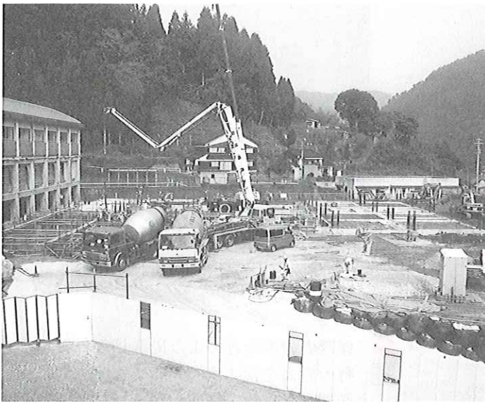
温泉小学校基礎工事
