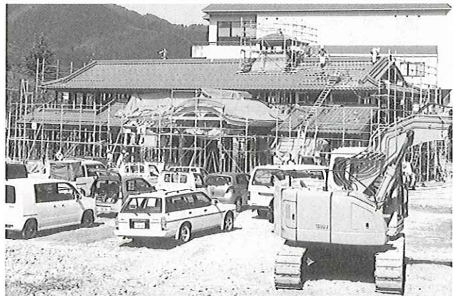
工事進む「新薬師湯」
