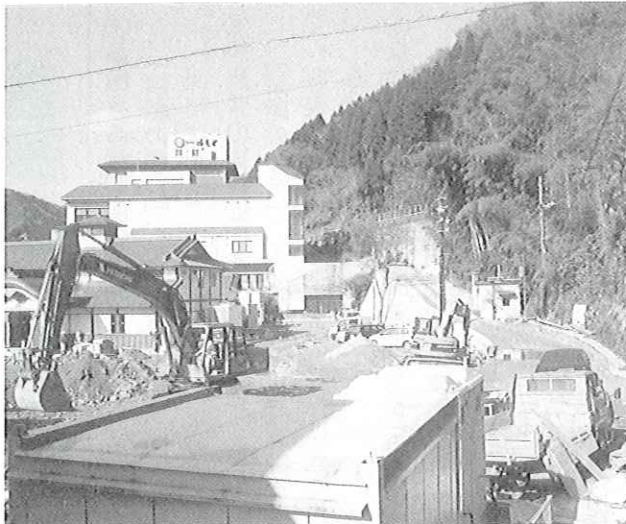
湯村温泉観光交流センター駐車場工事
