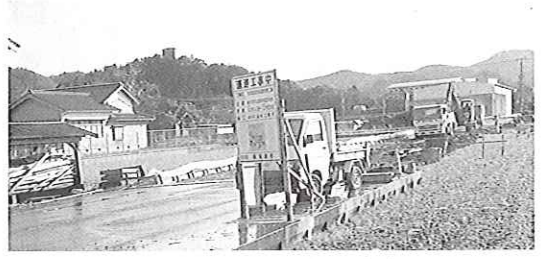
工事進む町道福富落合線
