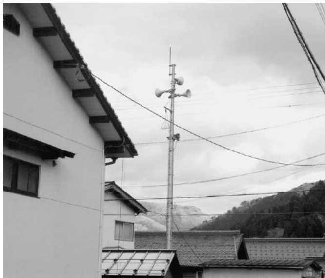
ケーブルテレビの屋外放送施設（竹田区）
