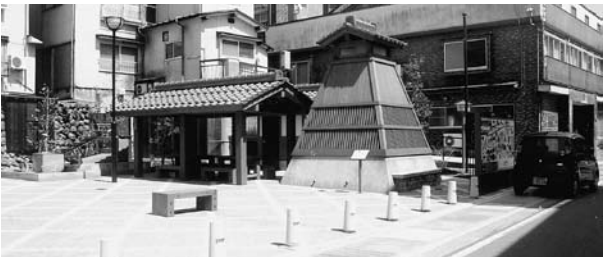
泉源の上屋棟（湯村温泉ポケットパーク）
