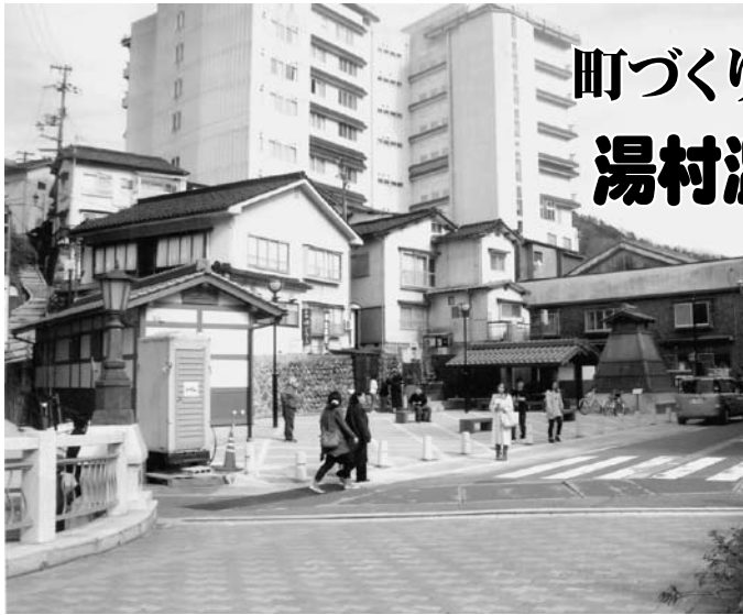
完成した湯村温泉ポケットパーク（旧薬師湯跡）
