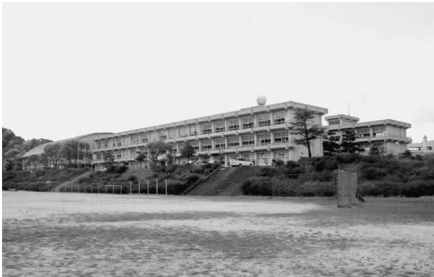
耐震化、大規模改造が行われる「浜坂中学校」
