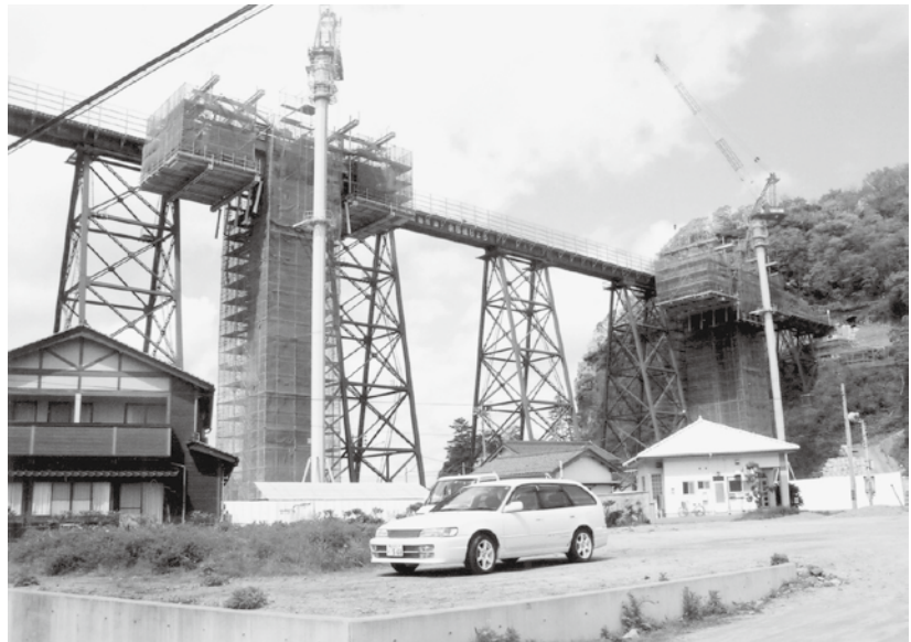
工事が進む「あまるべ鉄橋」
