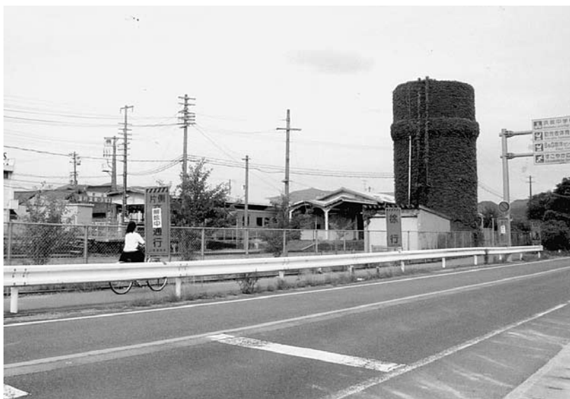
浜坂駅南北通路が計画されている駅の南側
