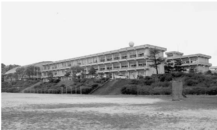
浜坂中学校耐震補強・大規模改造 南校舎から着目
