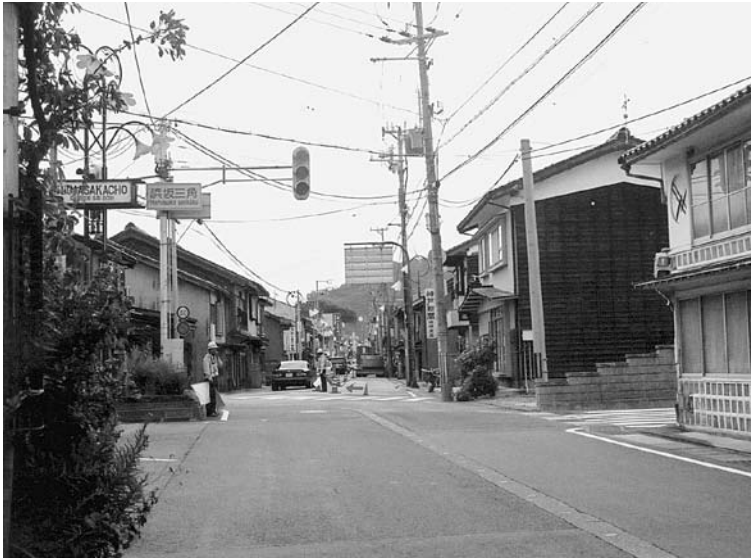
消雪設備の更新が行われた浜坂町内の県道
