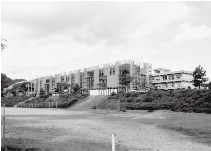
改造中の浜坂中学校
