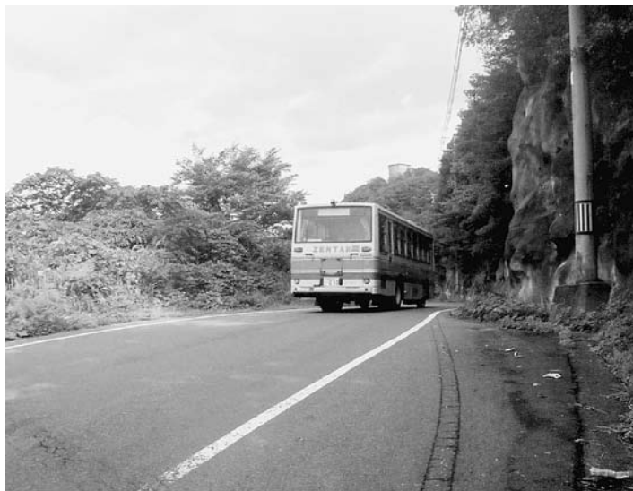
改良予定の町道二日市古市線
