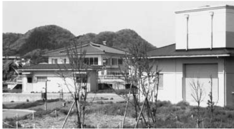
汚泥処理計画のある公共下水道施設
