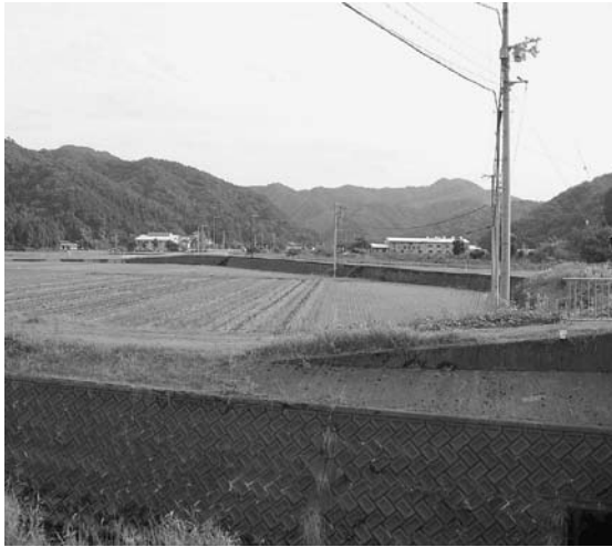
浜坂道路 浜坂東地区インター付近
