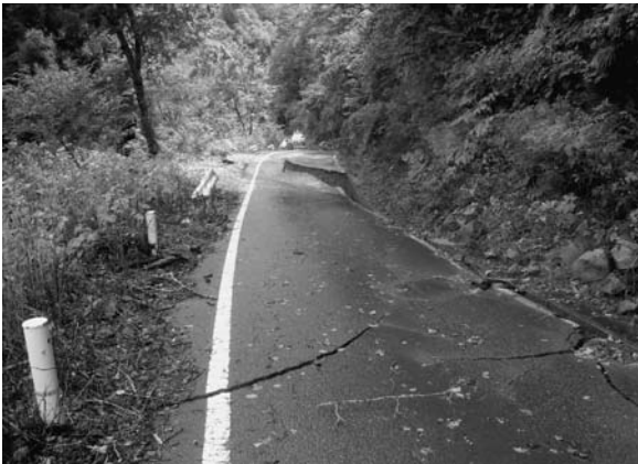
崩落した町道畑ヶ平線
