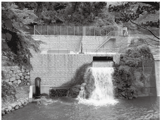
梼原町 小水力発電所
