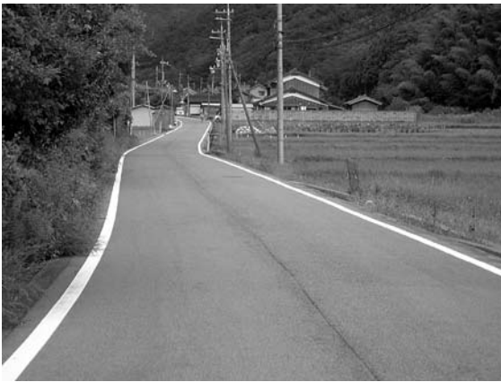
未整備がある県道三尾浜坂線（清富～田井間）
