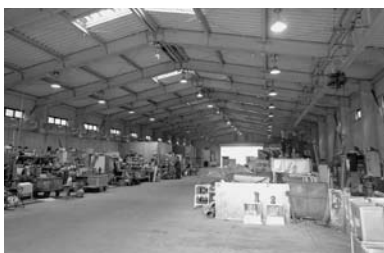
ストックヤードに不可能の久谷リサイクルセンター
