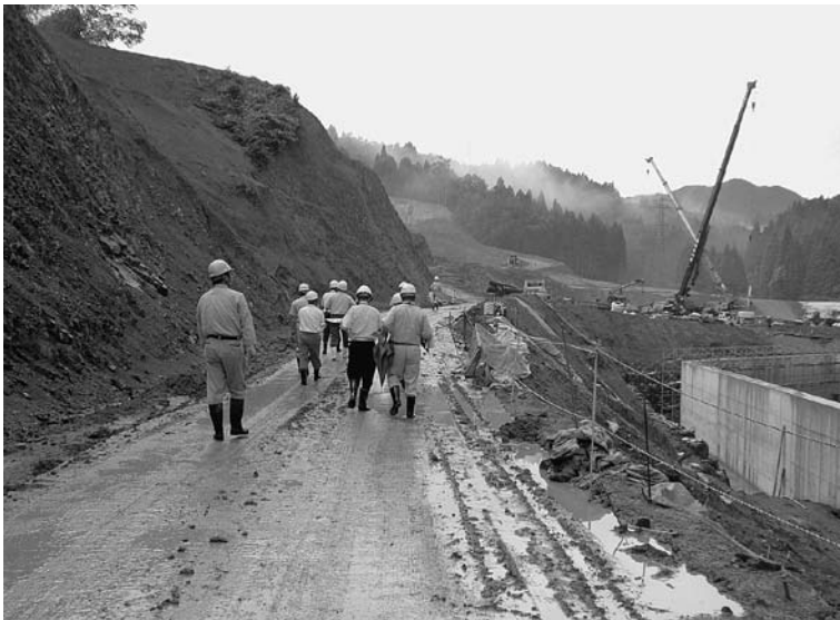
北但ごみ処理施設建設に向け進む進入道路・敷地造成工事
