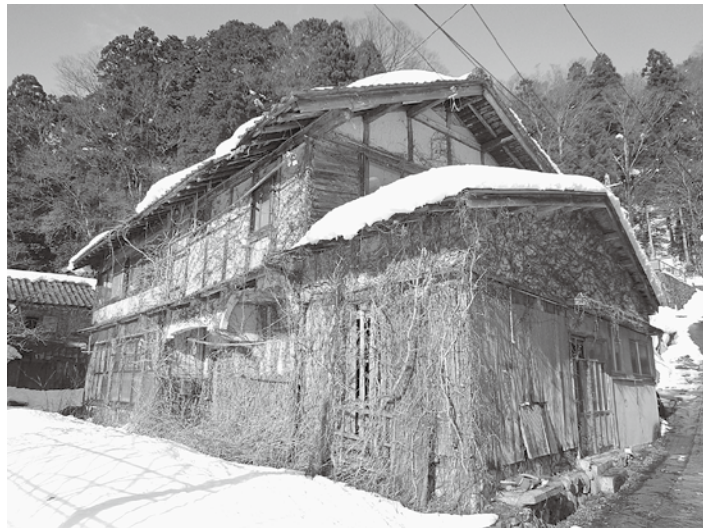
危険な空き家が増加
