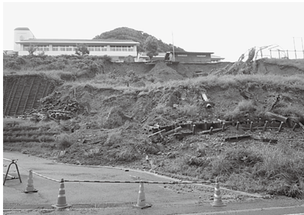
照来小学校 のり面崩壊現場
