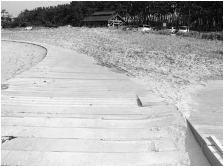
点検整備が必要な浜坂海岸ボードウォーク
