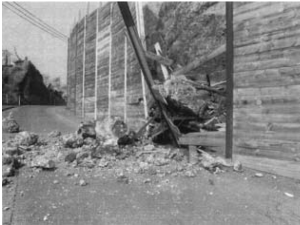
町道二日市古市線全面通行止め(2月24日〜5月10日)
