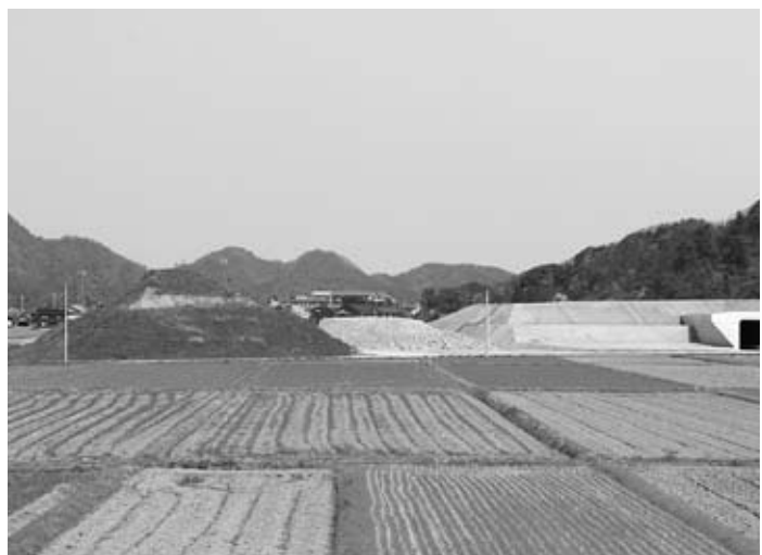
浜坂道路のインターチェンジ付近
