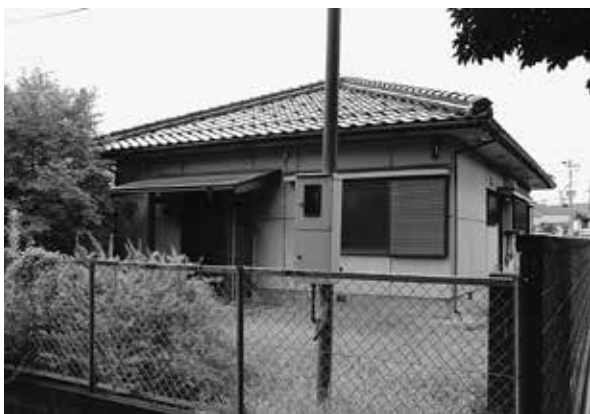
改修が決まった共同作業所建物（現医師住宅）
