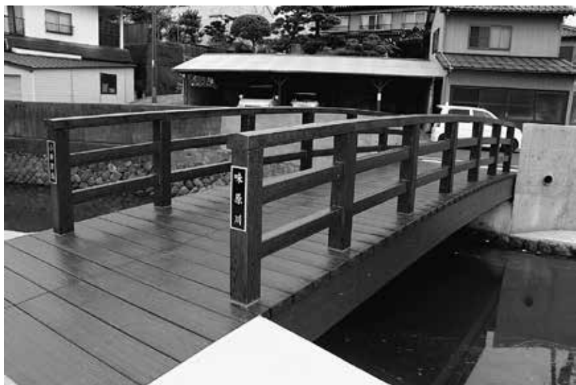
完成した味原川「小井津橋」
