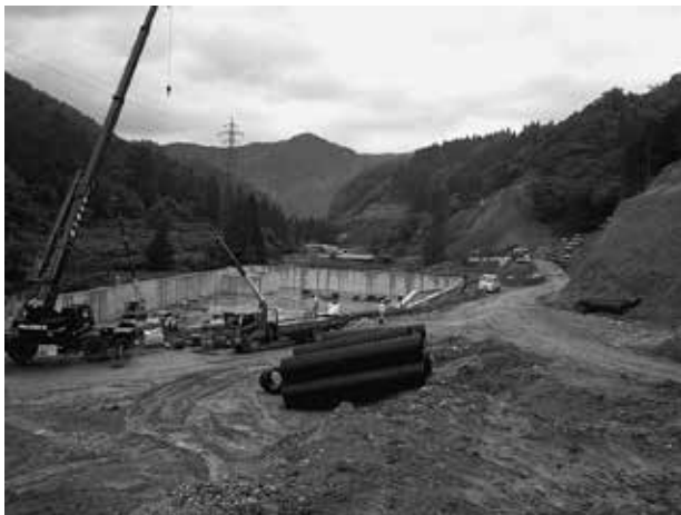
北但ごみ処理施設の建設状況
