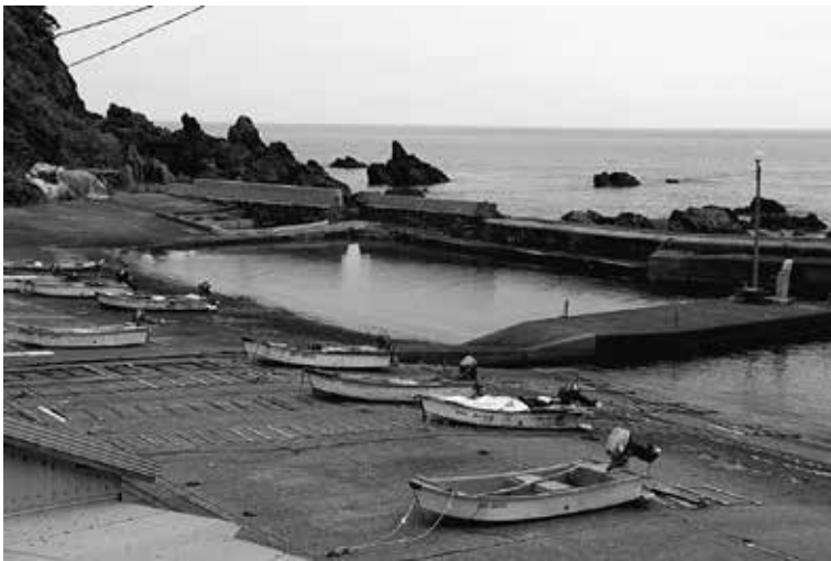
整備が急がれる「釜屋漁港」
