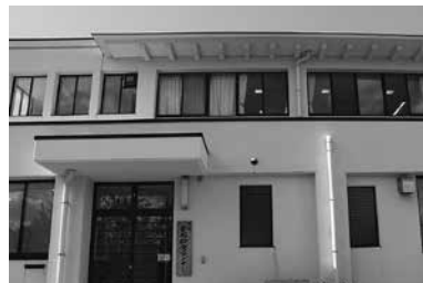
改修工事完工の総合給食センター
