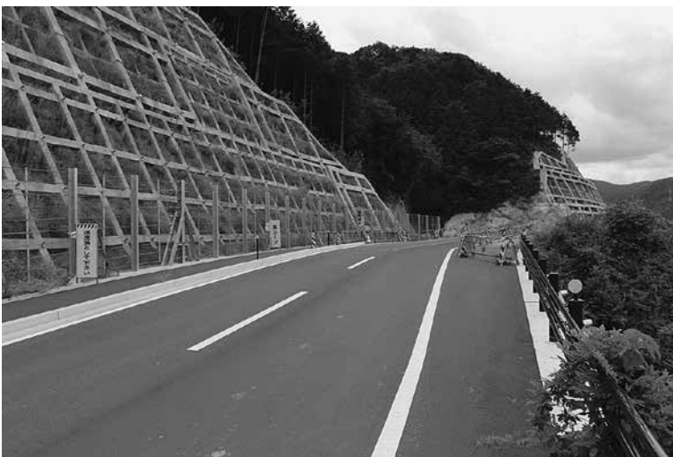
8億円で整備中の町道「二日市古市線（七釜・二日市間）」
