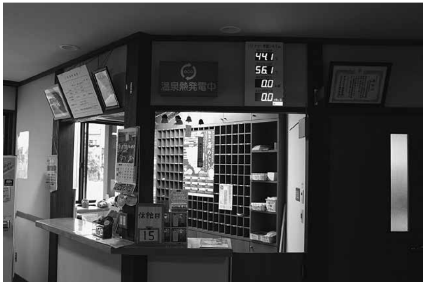
バイナリー発電の状況を表示するモニター（薬師湯受付）
