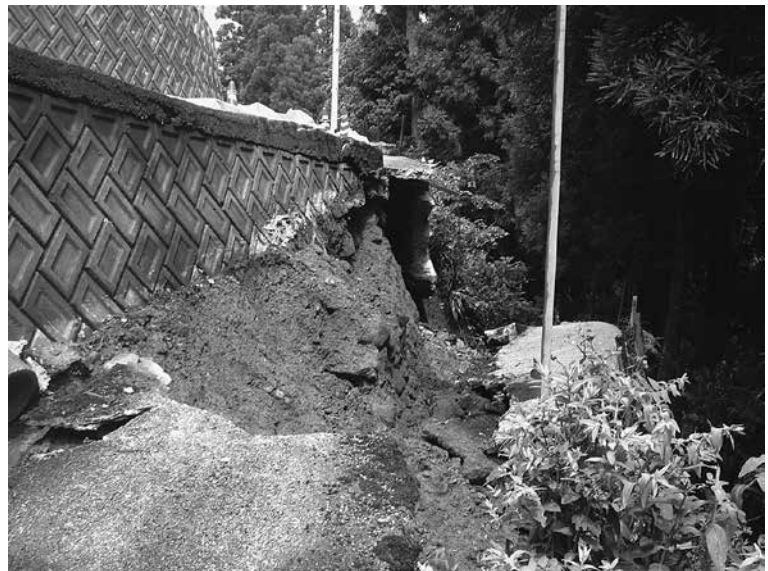
台風 11 号による災害発生 (内山地内)
