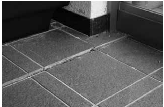
早期の耐震化工事が望まれる夢ホール。
