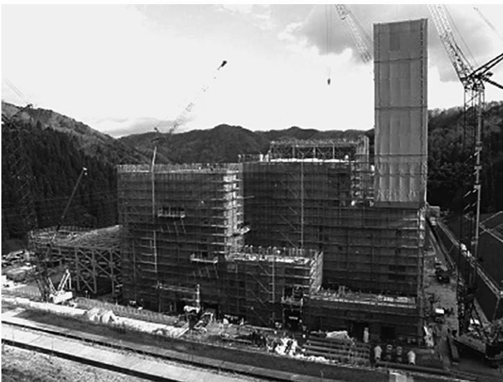
平成28年4月開設に向けて工事が進む「クリーンパーク北但」。スムーズな分別移行すべき。
