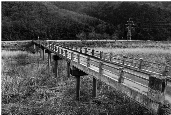
共用から55年が経過した「町道用土橋」。橋脚が多く増水時のダム化が危惧。
