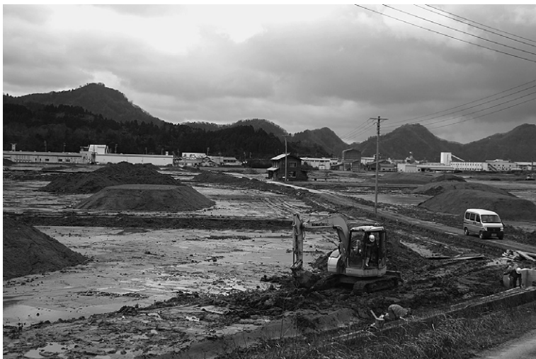
農業振興地域整備計画のもと順調に工事が進む大庭地区ほ場整備
