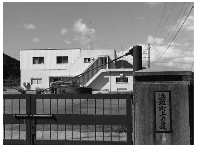
本町の上水道事業は人口減少や老朽化した施設の更新で経営難が継続。料金改定には町民に十分な説明が必要である。(写真は老朽化した新市浄水場)
