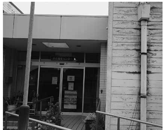
老朽化のため外壁のみならず雨漏りも発生している浜坂福祉センター。早急な全体改修が必要。
