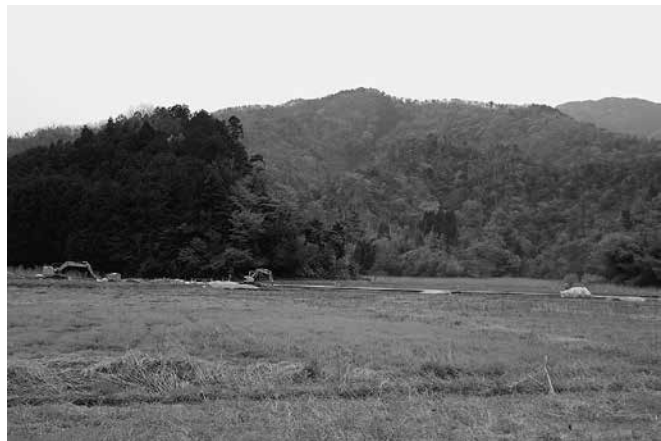
新残土処分場の開設のため進入路の整備が進んでいる。計画地は新温泉健康福祉事務所の裏手で写真の奥地。
