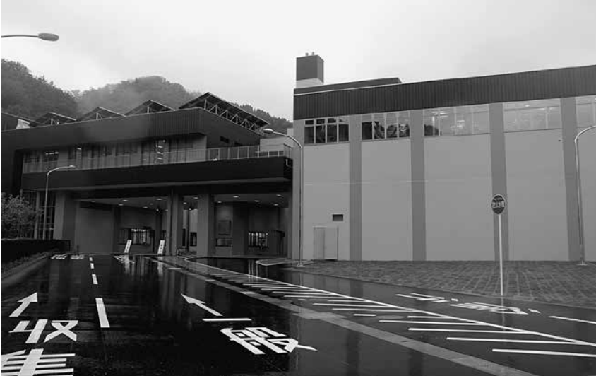
本年4月から焼却施設が稼働しているクリーンパーク北但。 8月7日には全体竣工式が予定されている。
