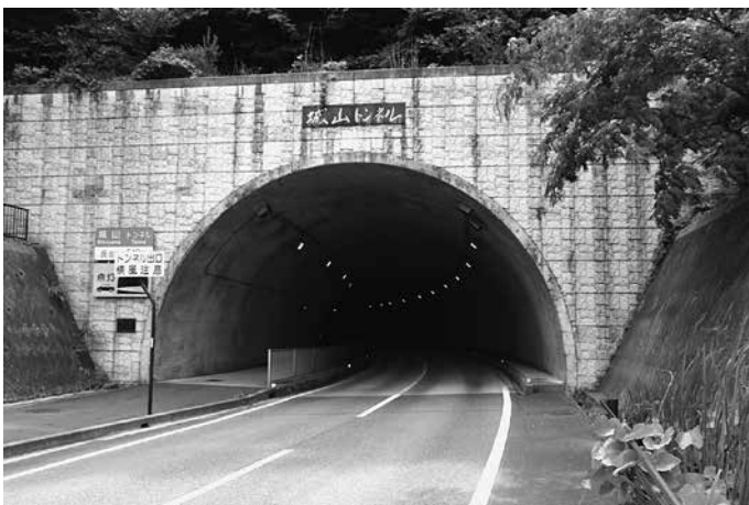
町道のトンネル照明が暗い状態だ。国のLED化に連動した対策を求めたい。
