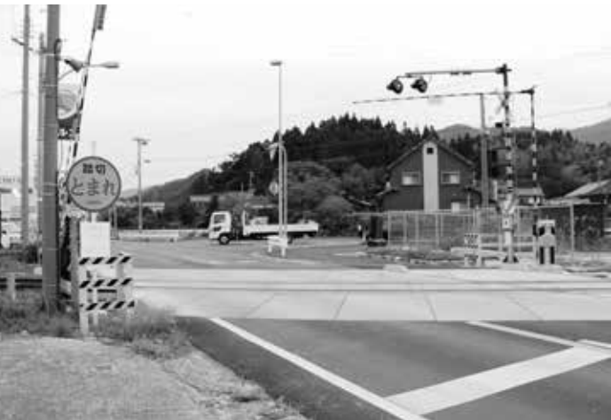
田君踏切の改良がなされたが、歩行者の安全対策が欠落している。早期の対策が必要である。
