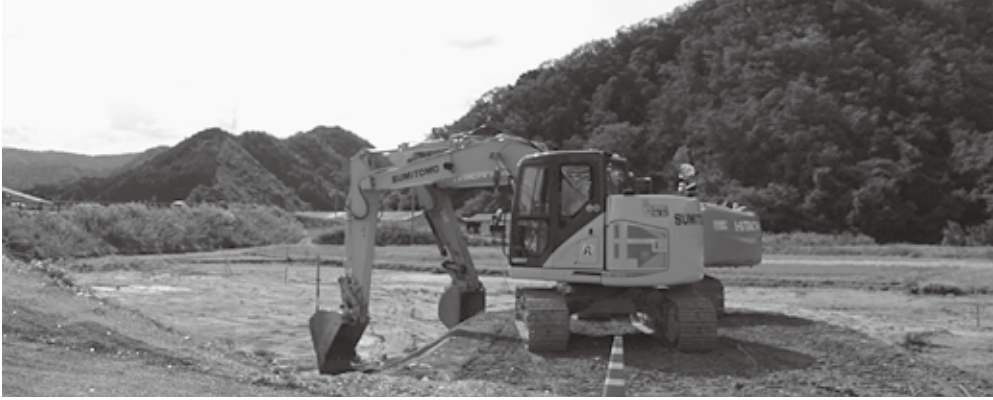
造成工事が進む道の駅、いよいよ建築工事がスタートする。 工期は来年7月21日である。
