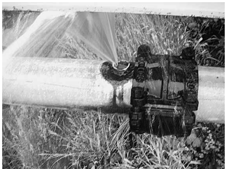
命の水を配水する配管は上水道の生命線。経年劣化した施設の維持経費は基本的に水道料金で対応するものだが…。
