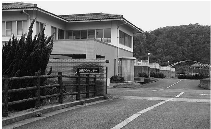
上水道と下水道は両輪で処理されるもの。しかし、料金改定は丁寧な住民説明と理解が求められる（浜坂浄化センター）。
