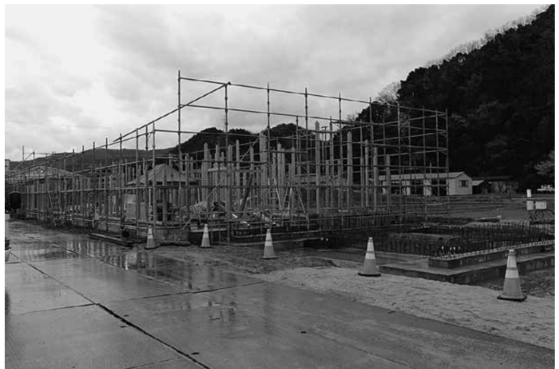
急ピッチで進む道の駅物販棟の建築作業。新鮮な地元野菜等の供給はオール新温泉で対応すべき。
