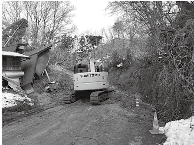
大雪による法面崩壊で大量の土砂が水路に流入。被害は隣接の農機具小屋にも及んでいる。(高山地区)
