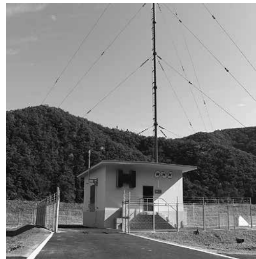
平成29年12月1日開局予定で工事が進むNHKラジオ中継局。明快な放送が楽しみです。(用土)
