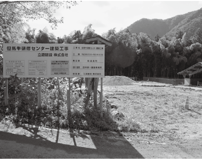
工事が進む但馬牛研修センター、完成は3月末(湯地内中山地区)
