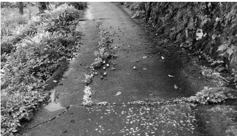
狭小道路整備事業の対象外である集落内道路は生活道路として重要だ。維持に対する制度を求めたい。
