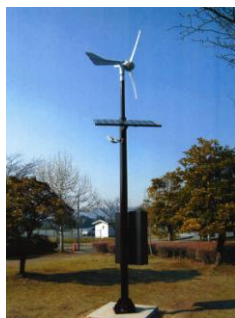
公園に設置された街路灯（竹田市） （小型風力発電と太陽光発電）
