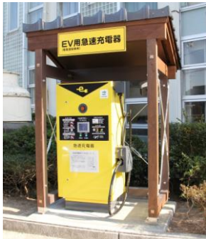
図 3-14 急速充電器 (電気自動車用)
