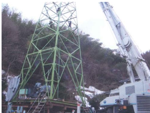
掘削機器の設営 12時間体制で掘削を行いました
